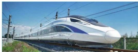
大量毕业生投身于国内外高铁建设
