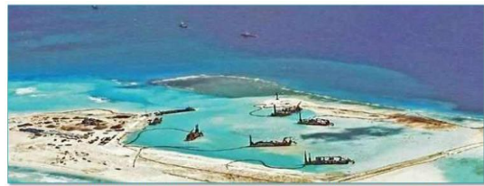
本专业毕业生参与南海吹沙造陆控制测量、疏浚工程
